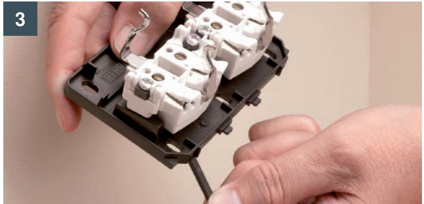
Beim Einsatz des SL-Kanals der Kanalhöhe 70 mm, die beiden Stege (Abstandshalter) abbrechen.
